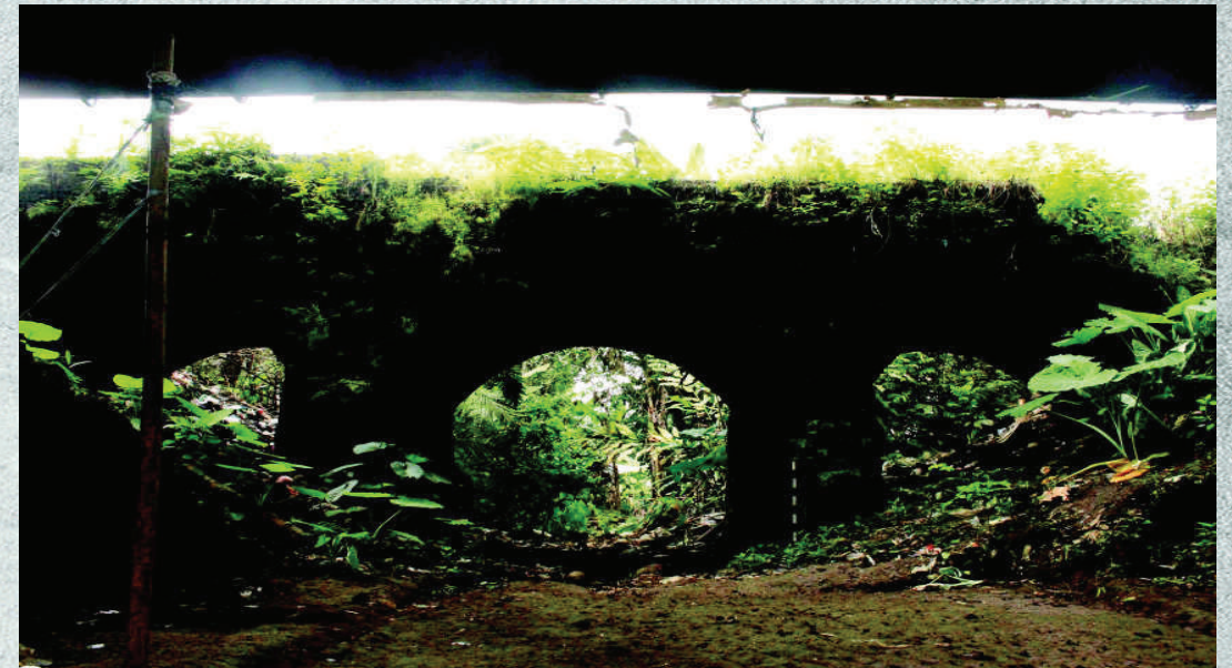
Viaduct Labuan, rel kereta berada di bawah jalan raya
