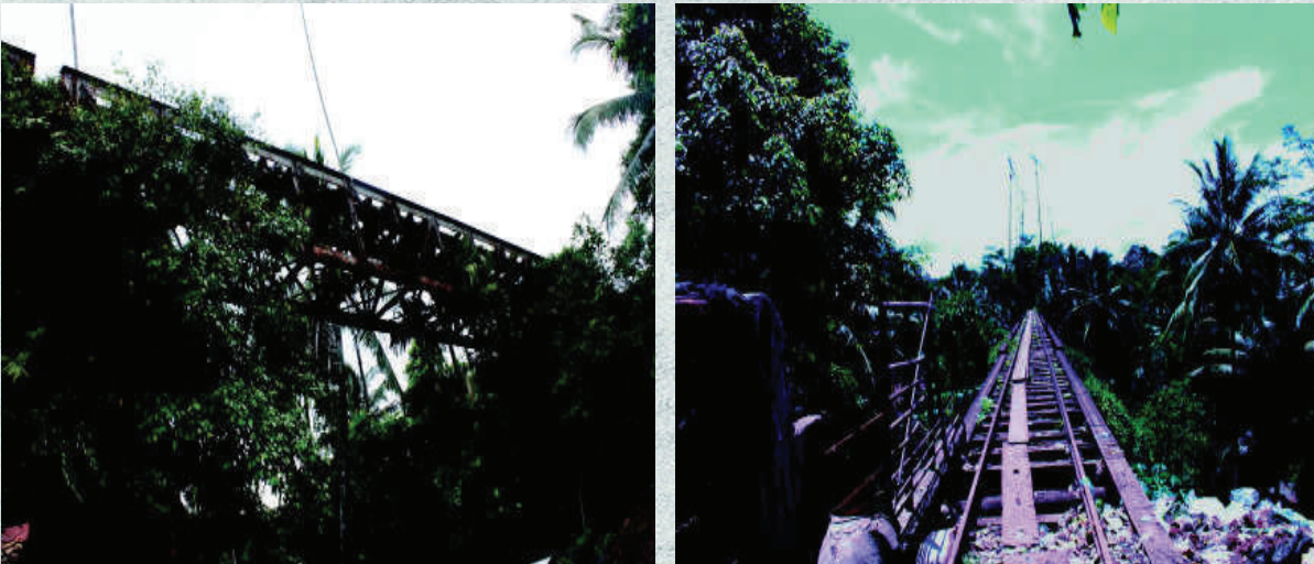
Jembatan Lebak Saketi (Kiri : Tampak bawah ; Kanan : Tampak atas)
