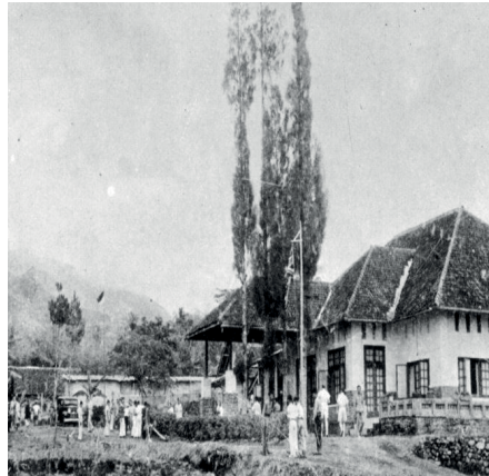
Gedung Perundingan Linggarjati Sumber: www.tourdelinggarjati-kuningan.com
