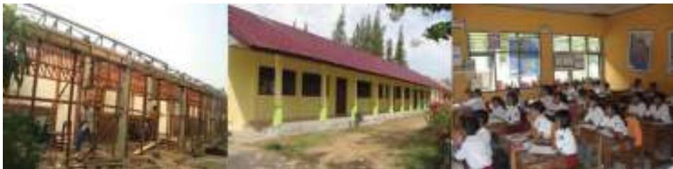
Sumber: www.Jakarta.go.id , saranakomunitas.net , Sumber: bs135.blogspot.com Gambar 1.8 dan 1.9 Pembangunan gedung sekolah Gambar 1.10 Sekolah
