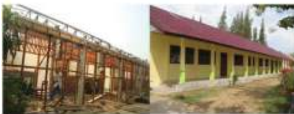
Sumber: www.Jakarta.go.id, saranakomunitas.net Gambar 1.10 dan 1.11 Pembangunan gedung sekolah
