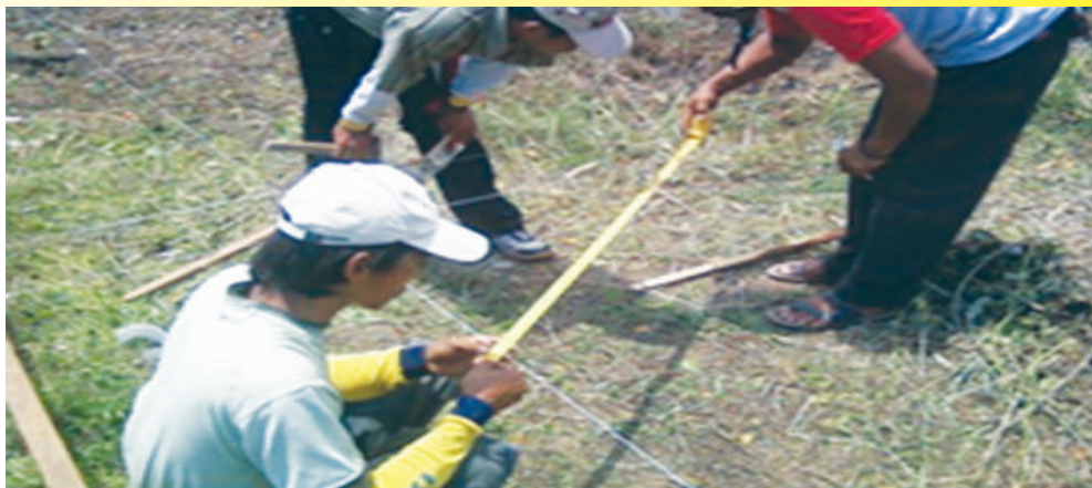
Gambar 6.1 Seorang Tukang sedang mengukur kesikuan lahan
