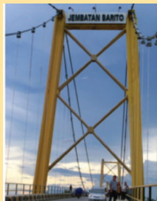
(ii) Jembatan Barito
