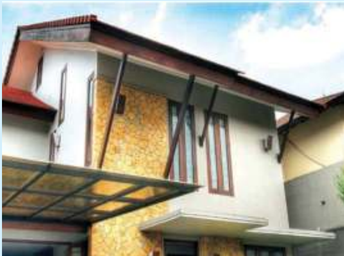
Gambar 1.9: Tiang Penyangga Atap Bangunan
