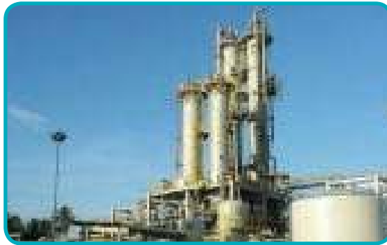
(Sumber: www.arahmah.com ) Gambar 3.12 Bangunan industri
