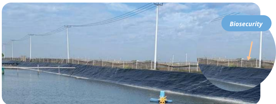
Gambar 7.5 Tambak Udang dengan Sistem Biosecurity Berupa Pagar Keliling Sumber: Rahayuningtyas (2022)
