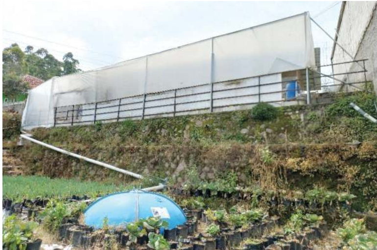
Gambar 4.16 Instalasi pengolahan limbah pertanian dan ternak untuk produksi biogas
