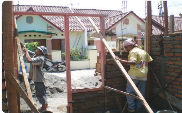
Gambar 3.10 Pekerjaan Kusen Sumber: Winarko (2022)
