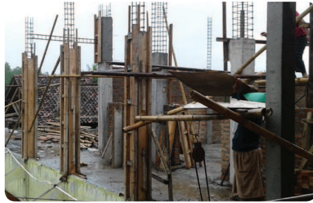
Gambar 3.5 Pekerjaan Kolom Sumber: Winarko (2022)
