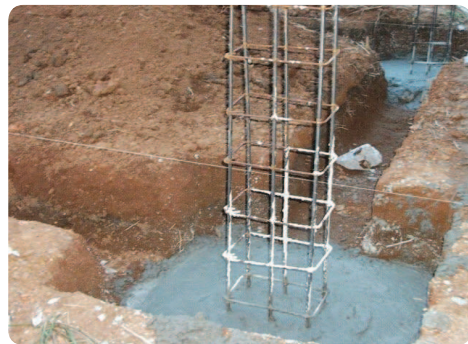
Gambar 3.3 Pekerjaan Fondasi Footplat Sumber: Winarko (2022)
