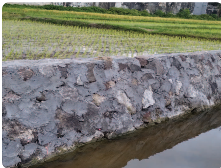
Gambar 3.2 Pekerjaan Fondasi Batu Kali Sumber: Winarko (2022)
