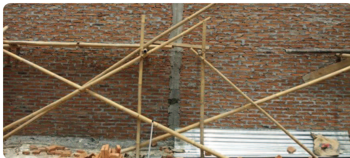
Gambar 3.7 Pekerjaan Dinding Sumber: Winarko (2022)
