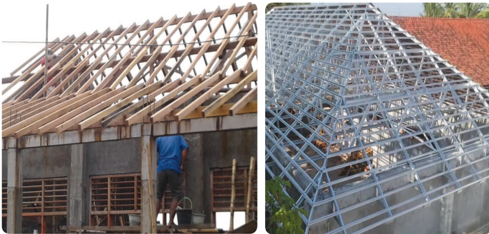
Gambar 3.11 Pekerjaan Atap Sumber: Winarko (2022)
