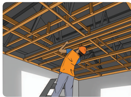
Gambar 3.13 Pekerjaan Plafon Bahan Kayu Sumber: Al Faruq/www.alfaruqtukangaceh.com (2021)
