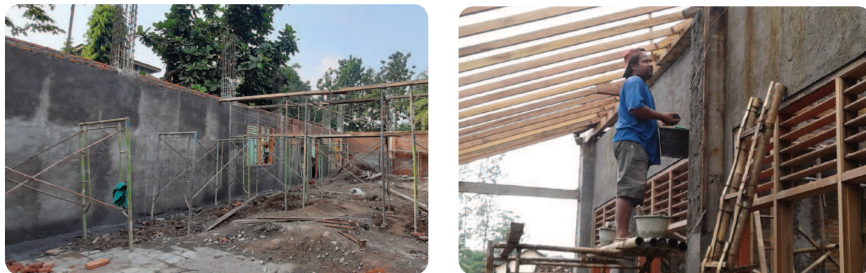
Gambar 3.8 Pekerjaan Plesteran dan Acian Sumber: Winarko (2022)
