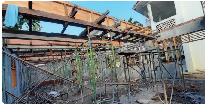
Gambar 3.6 Pekerjaan Balok Sumber: Winarko (2022)
