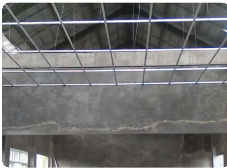
Gambar 3.12 Pekerjaan Plafon Bahan Baja Hollow Sumber: Winarko (2022)
