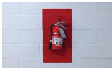
**Gambar 5.8** Alat pemadam kebakaran ringan (APAR) merupakan salah satu alat yang disediakan di laboratorium.
