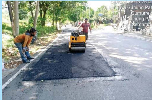
Gambar 5.35 Pelaksanaan pekerjaan perawatan jalan yang berlubang di jalan raya dan di atas jembatan. Sumber: Kevin Ramone (2023)
