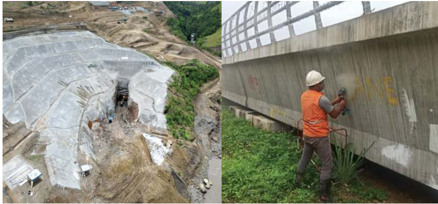
Gambar 5.3. Pekerjaan perawatan konstruksi bangunan sipil.
