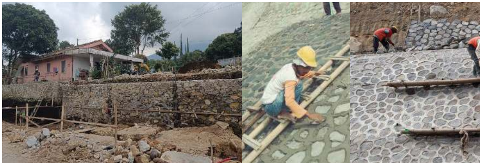
Gambar 5.25 Pekerjaan pemasangan batu kali.
