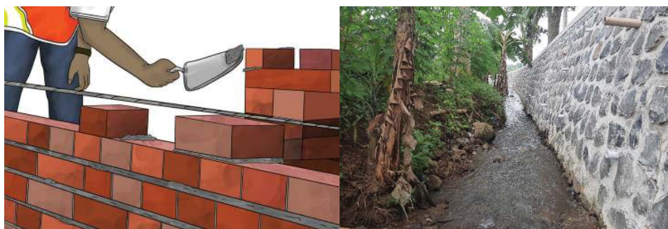
Gambar 5.26 Pekerjaan pemasangan dinding.
