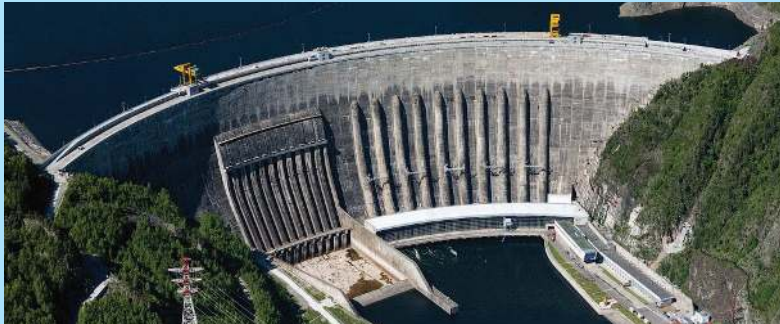
Gambar 5.21 Salah satu bangunan yang ada di konstruksi bangunan sipil.
