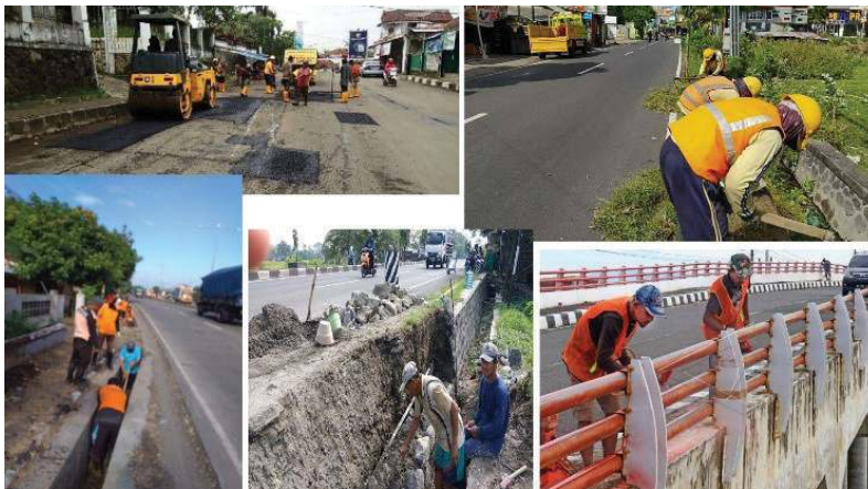
Gambar 5.36 Pelaksanaan perawatan pada prasarana infrastruktur jalan dan jembatan.
