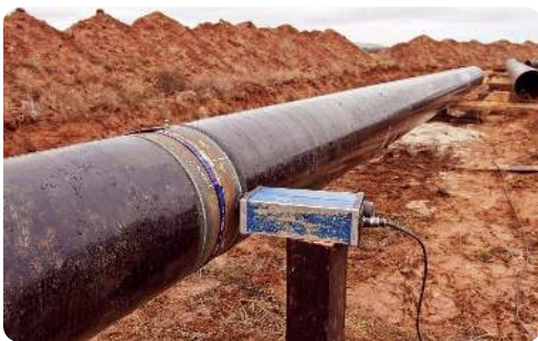
Gambar 11.13 Penerapan Perlindungan Katoda
