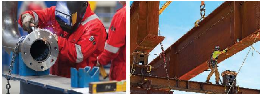
Gambar 1.9 Kegiatan fabrikasi logam pada proyek konstruksi.
