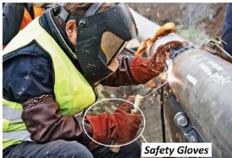
Gambar 4.15 Sarung tangan las dan penggunaannya pada waktu pengelasan.
