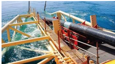
Gambar 1.15 Proses instalasi pipa gas di dalam laut.
