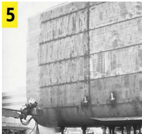
5 Membersihkan permukaan material dinding kapal sebelum pengecatan
