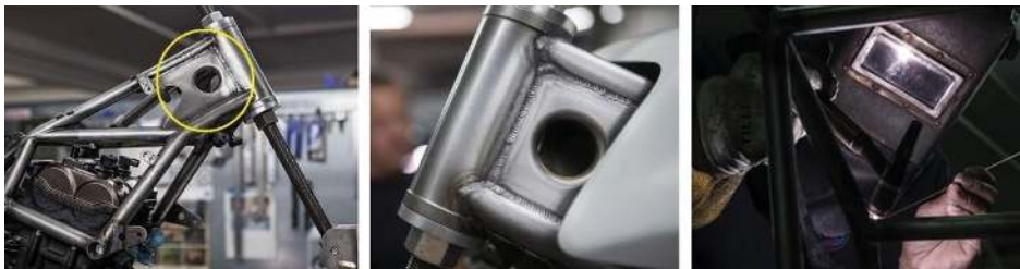
Gambar 2.21 Mengelas rangka sepeda motor dengan GTAW Welding.
