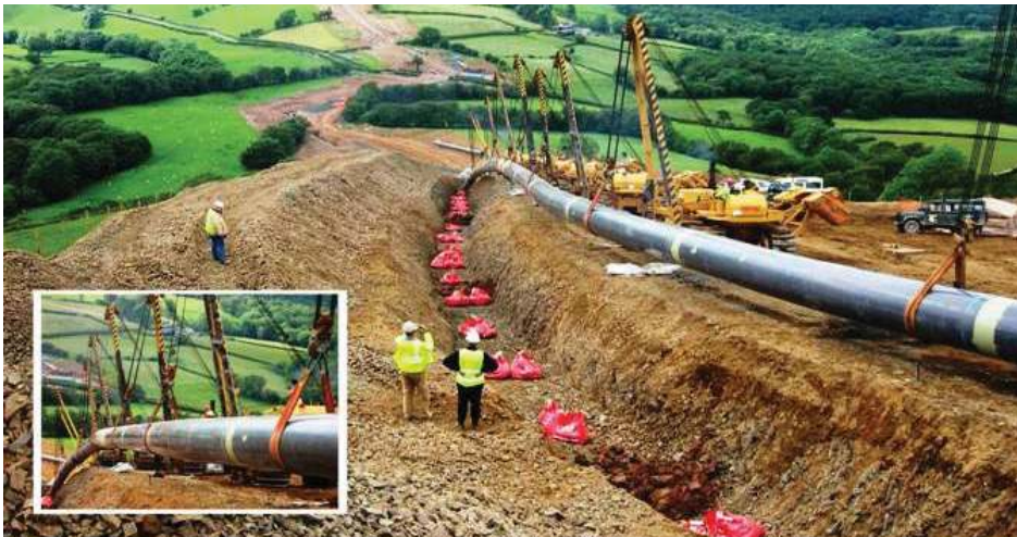
Gambar 1.14 Pemasangan pipa air dengan aliran gravitasi di dalam tanah.
