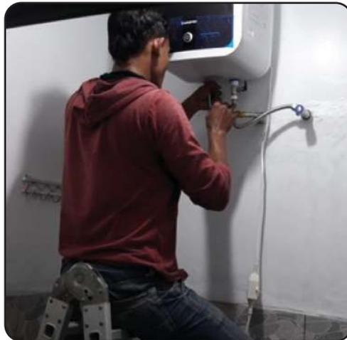
Gambar 1.33. Teknisi pemasangan Waterheater
