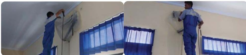
Gambar 3.26. Peralatan perawatan AC dan Pencucian AC Split
