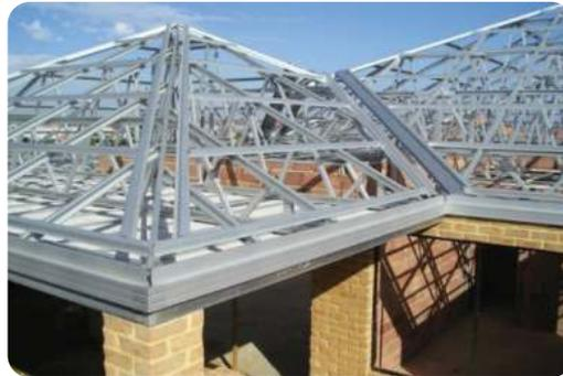
Gambar 4.4. Rangka Atap Baja Ringan
