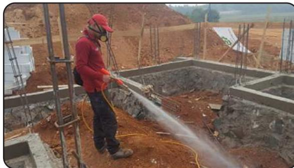
Gambar 4.11. Perawatan Pondasi Semprot Anti Rayap
