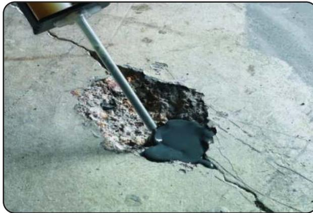
Gambar 4.12. Perawatan Retak Beton
