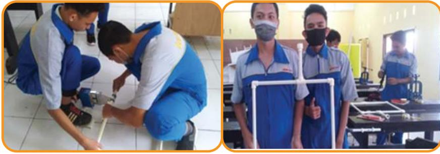
(e) Penyambungan pipa PPR dengan pemanas pipa PPR
