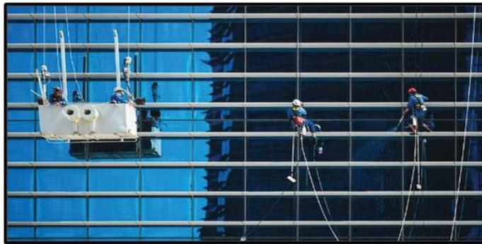
Gambar 1.4. Pekerjaan Perawatan dan Pemeliharaan
