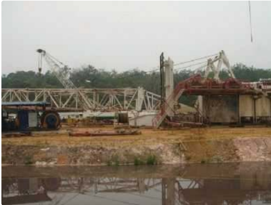
Gambar 6.7 Bagian Dasar Menara Diangkat ke Lantai Rig Sumber: PPSDM Migas Cepu/Susilo (2012)
