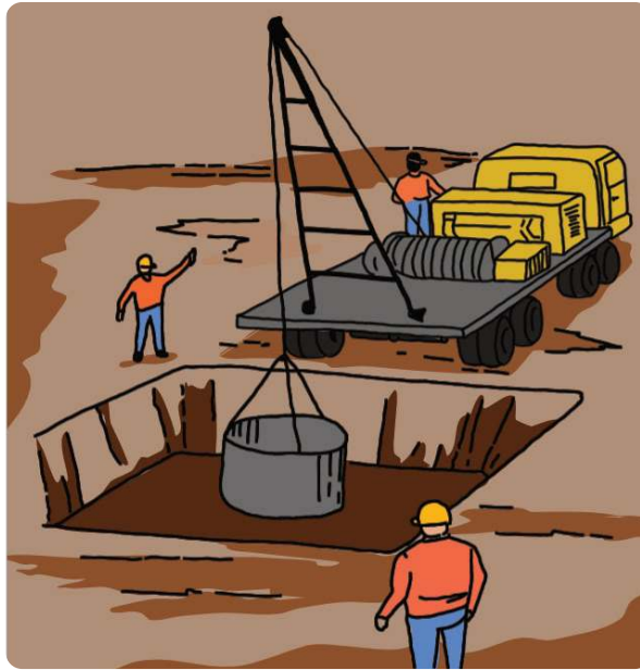
Gambar 5.11 Pembuatan Lubang Stove Pipe dan Pemasangan Stove Pipe
