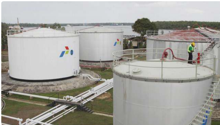
Gambar 4.8 Pengambilan Sampel Minyak di Tangki Timbun Sumber: Antara Foto/Rivan Awal Lingga
