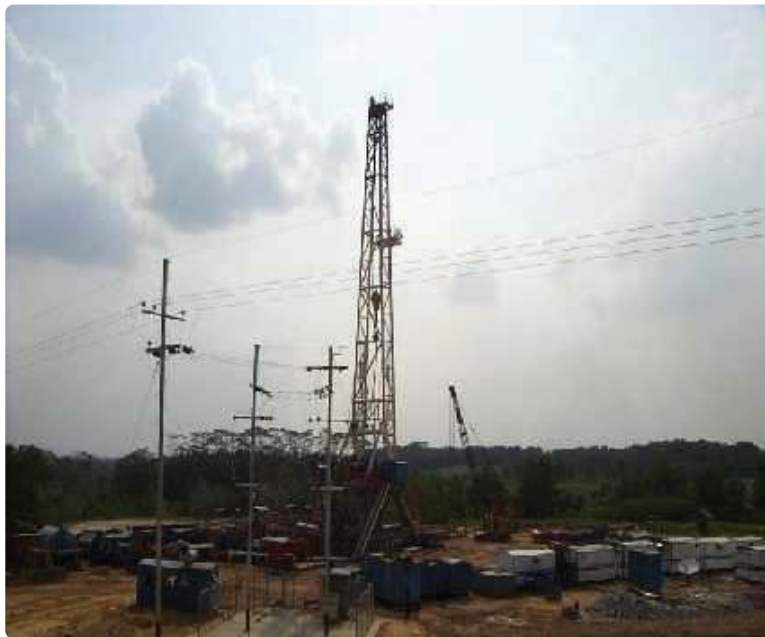
Gambar 6.10 Pekerjaan Penyelesaian Akhir Sumber: PPSDM Migas Cepu/Susilo (2012)
