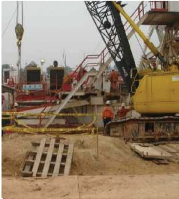
Gambar 6.9 Peralatan Dipindahkan ke Posisinya Sumber: PPSDM Migas Cepu/Susilo (2012)
