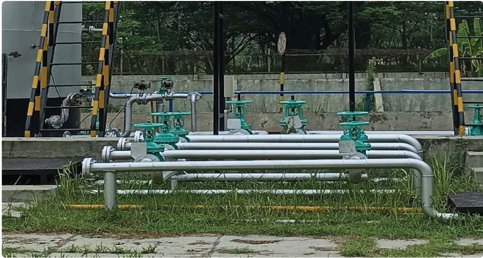
Gambar 7.24 Manifold Sumber: Siska (2023)
