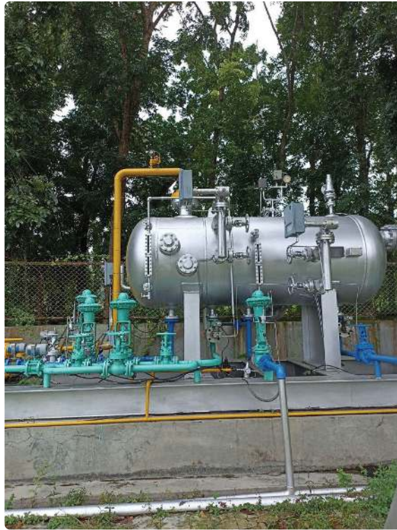
Gambar 8.5 Separator Sumber: Siska (2023)
