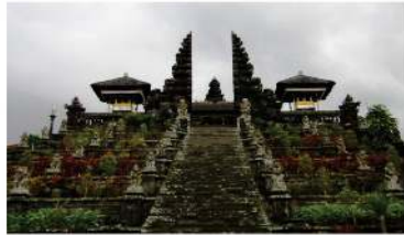
Pembangunan dan renovasi Pura
