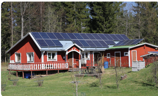
Gambar 7.6 Panel surya di atap rumah.
