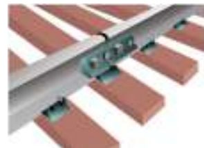
Gambar 3.14 Sambungan rel kereta api dibuat berongga.
