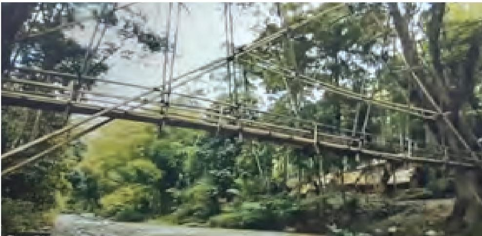
**Gambar 10.2.**Jembatan bambu yang merupakan kearifan lokal teknologi pembuatan sarana jalan dari daerah
