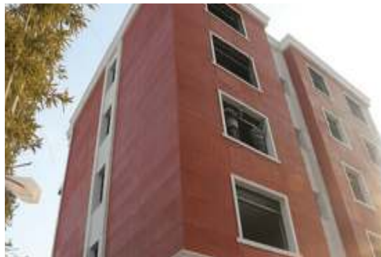
Gambar 1.6 Gedung tertinggi yang dibangun dengan 3D printing Sumber: theguardian.com/WinSun (2015)
