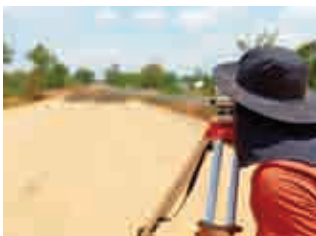
Gambar 4.2 Menggunakan Theodolit
