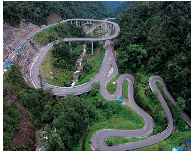
Jembatan Layang Kelok Sembilan, Sumatra Barat
