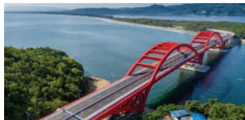
Gambar 3.3 Pembangunan Infrastruktur di Provinsi Papua
