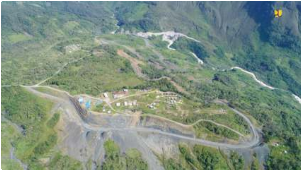
Gambar 1.7 Proyek Jalan Trans-Papua, Bagian dari Pemerataan Pembangunan
