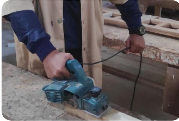
Gambar 4.70 Mengetam dengan ketam tangan listrik
