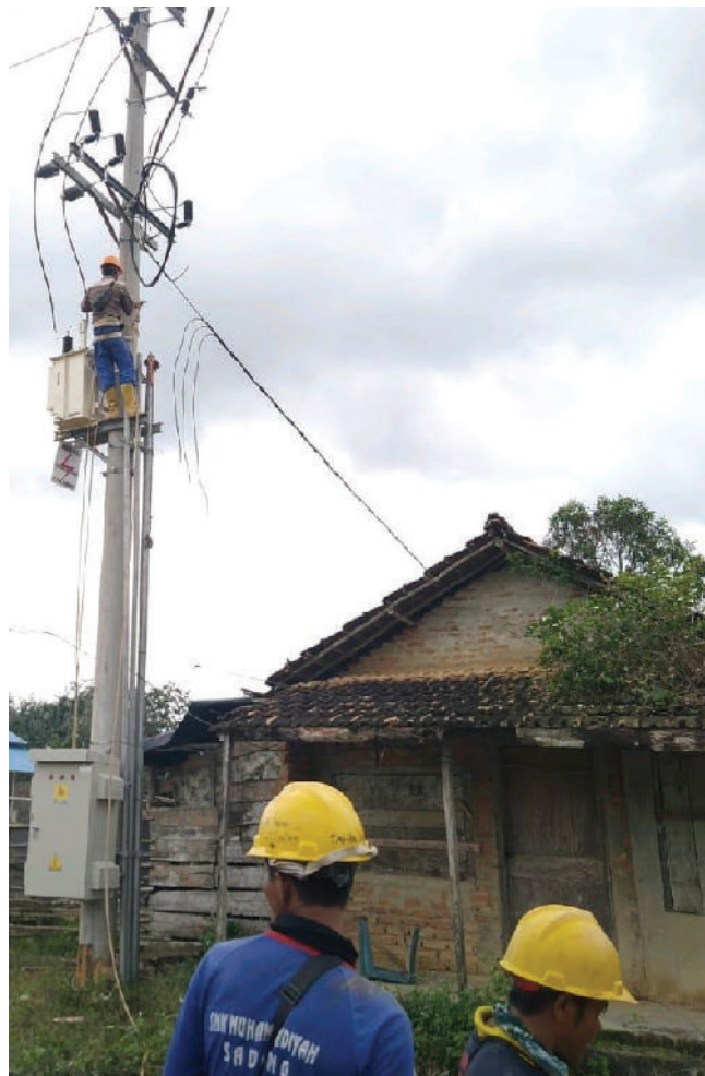
Gambar 1.7 Proses Penyambungan Jaringan Distribusi ke Pelanggan di Kabupaten Ogan Komering Ilir (OKI), Sumatera Selatan.
