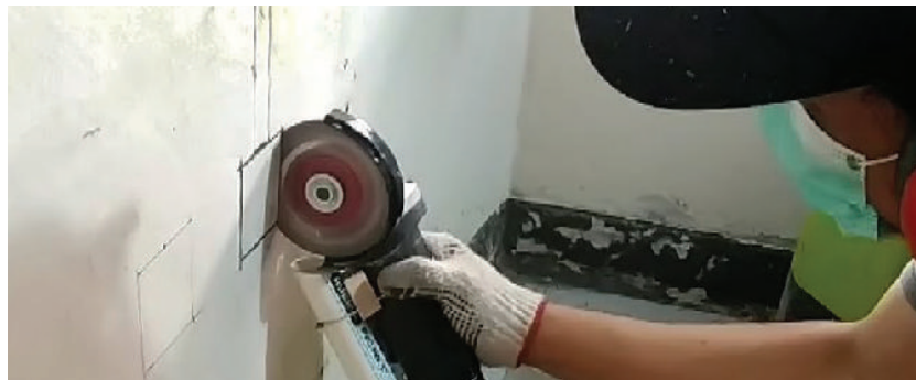
Gambar 4.25 Pekerja Mengiris Tembok Menggunakan Gerinda untuk Membuat Lubang
