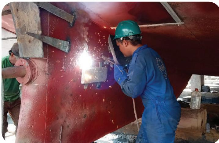
Gambar 1.6 Pengelasan Komponen Konstruksi Kapal Baja
